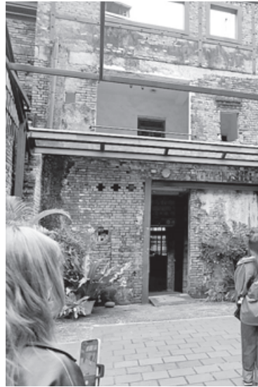
写真5：剥皮寮歴史街区のレンガ造りの建物。補強して利用されている。筆者撮影。
